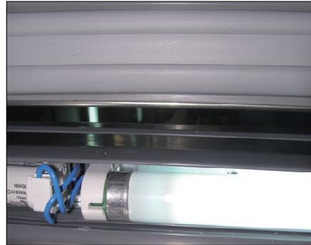
4. Ziehen Sie die Röhre heraus und ersetzen Sie sie durch eine andere Röhre mit ähnlichen Eigenschaften. Die Leistung der Röhre ist auf dem Gehäuseschild und auf dem Typenschild des Geräts angegeben.
