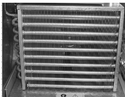
Condensador limpo
