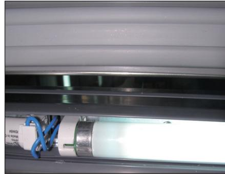
4. Leuchtstoffröhre entnehmen und durch eine neue mit gleichen Kenn-daten ersetzen.
